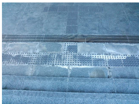
ブロックの傷み&溝による中断
