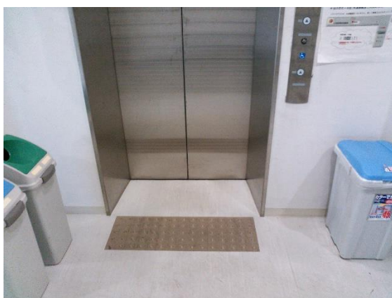
ボタンの前に設置しないと、車輪が引っ掛かるため車いすの邪魔になる
